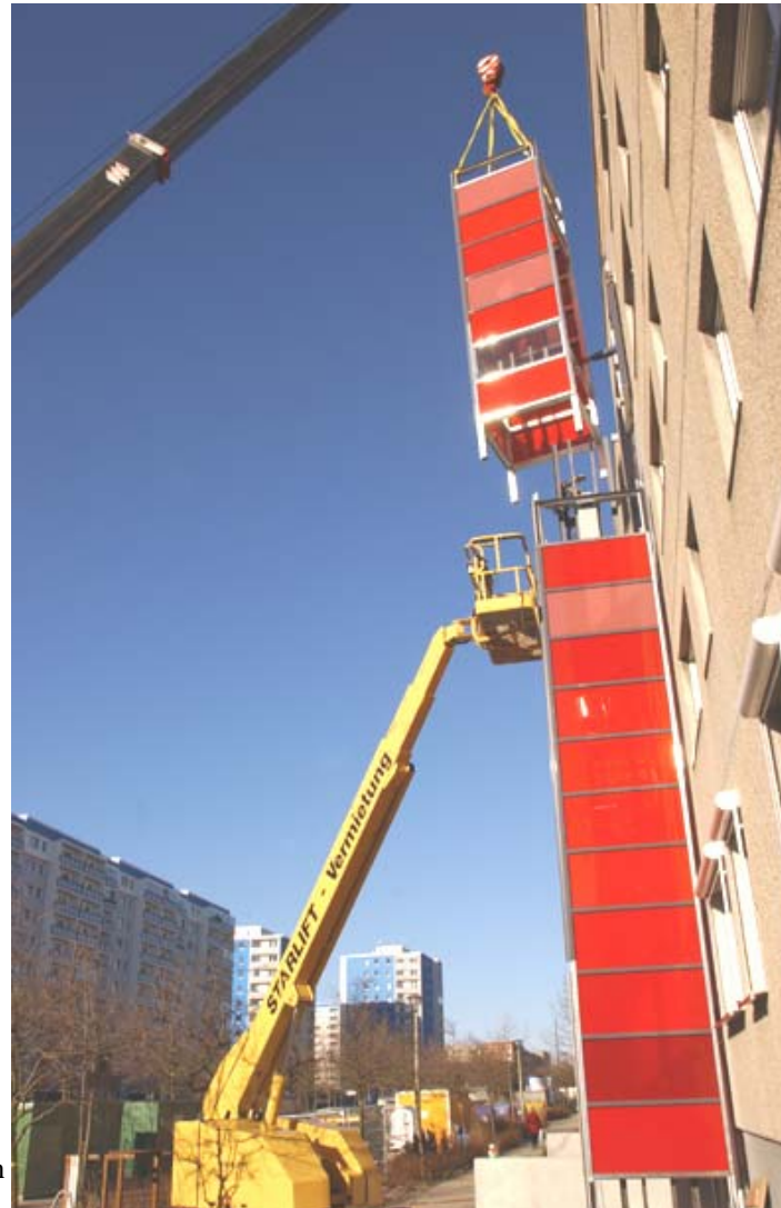
Anbau von Aufzügen zum Abbau von Ausstattungsdefiziten
